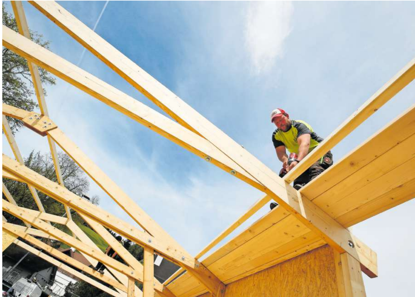
Die Arbeiten laufen auf Hochtouren: Stefan Heinzer beim Stand der Iten & Henggeler Holzbau AG.
